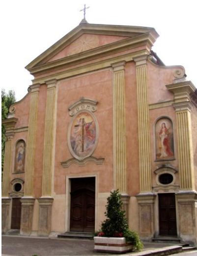
Villastellone – Chiesa S. Croce
